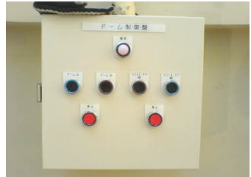
ドーム制御盤（外部）
