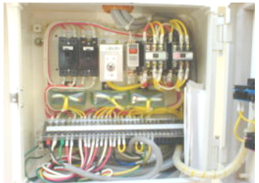
ドーム制御盤（内部）
